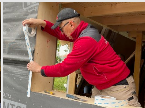
Paropriepustná membrána z exteriéru sa prilepí vzduchotesnou páskou k osteniu.
