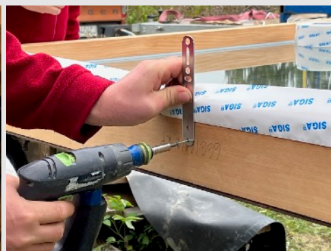
Prilepí sa páska a naskrutkujú kotviace prvky.
