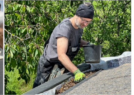
Oloženie štrku po okrajoch strechy, vymedzených štrkovou kovovou lištou, zaťaženou vrstvami zelenej strechy.
