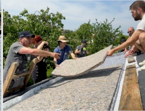
Oloženie 2. retenčnej vrstvy - rohože z recyklovaného prírodného textilu (20mm), napustené výživou - nahrádzajú substrát.
