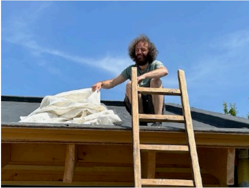
Oloženie geotextílie (300 - 500g), prvej vrstvy, ktorá je v tomto prípade ochranná.
