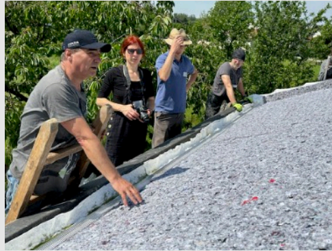
Oloženie retenčnej a drenážnej vrstvy - rohože z recyklovaného syntetického textilu (20mm)
