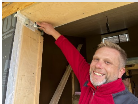
Najprv sa zabezpečí vzduchotesnosť ostenia - pri drevostavbách vzduchotesnou páskou.
