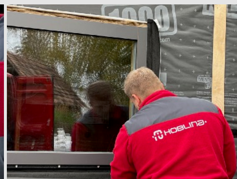
Keď je okno zafixované do ostenia, inštalačná medzera sa vyplní povrazcom z ovčej vlny.
