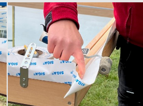
Na rohoch sa páska nechá dlhšia, aby kompenzovala veľkosť inštalačnej medzery.
