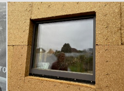
Rám sa prekryje drevoláknitou doskou, ktorá sa montuje na panely z exteriéru.
