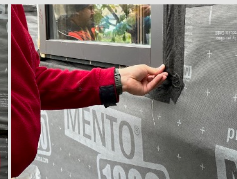
Z exteriéru sa rám prilepí vodeodolnou paropriepustnou páskou k membráne.
