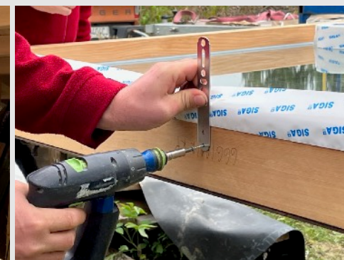
Prilepí sa páska a naskrutkujú kotviace prvky.
